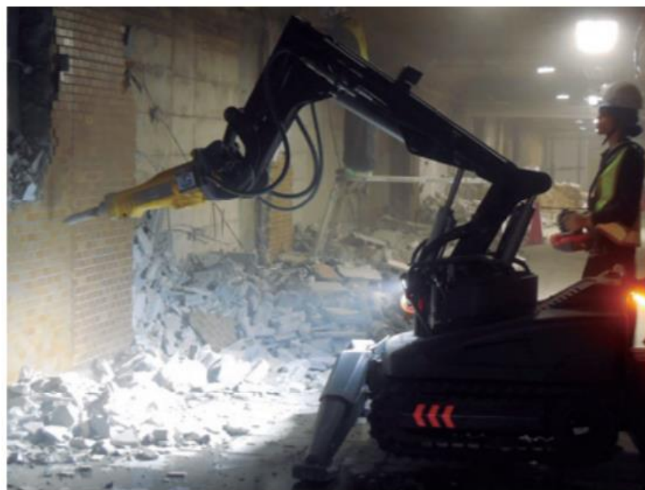
DXR 140 による屋内解体作業の様子
