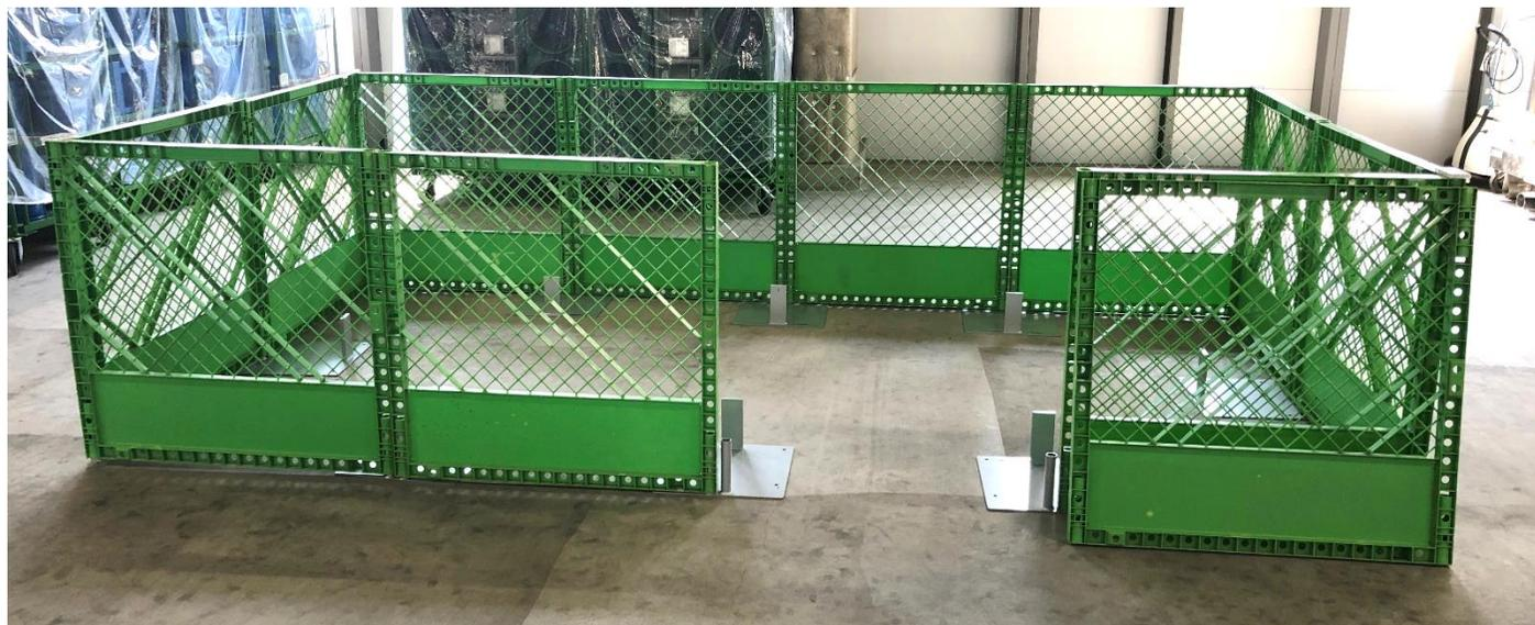
5. 出入口用控え材を左右に装着し、他のベースプレートにも控え材を装着します。
