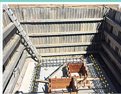
配水管不断水バルブ設置工事
