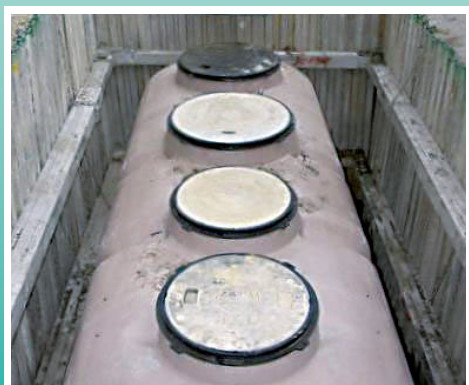
浄化槽設置工事
