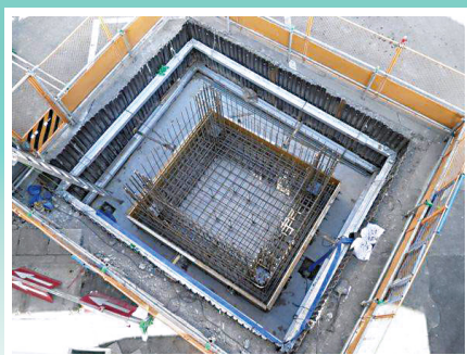
歩道橋エレベータ基礎工事
