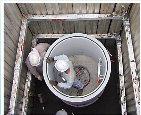
下水道マンホール設置工事
